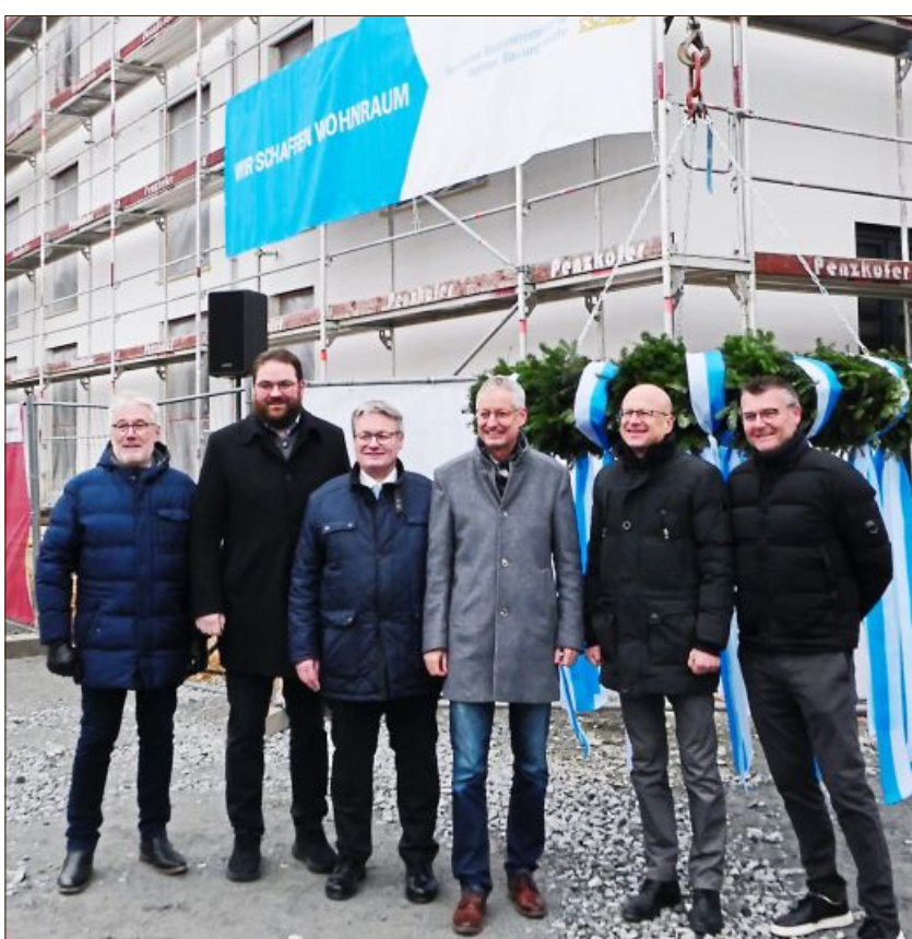
Die Ehrengäste beim Richtfest „An der Schlesischen Straße“. Fotos: Ulli Scharrer
